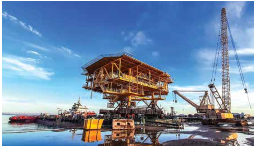
Khối thượng tầng giàn RC-10 được hạ thủy thành công. Ảnh: Vương Thái
